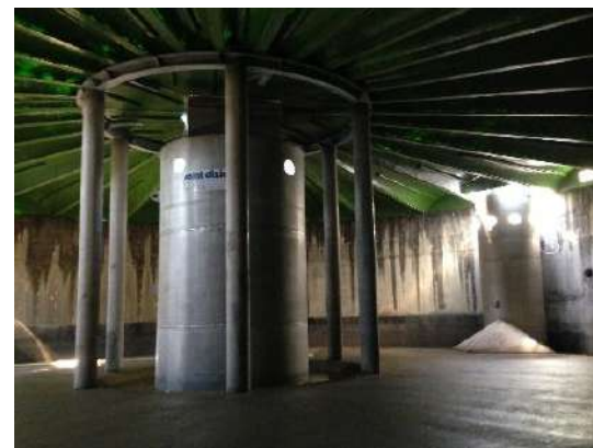
Equipements de bassins
