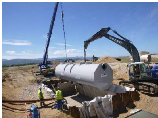
Séparateurs à hydrocarbures
