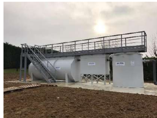
Traitement des eaux pluviales
