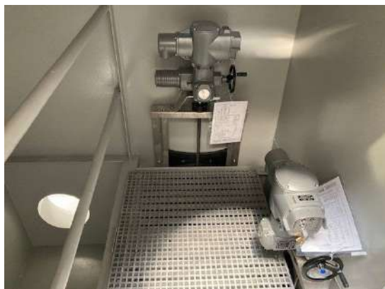
Isolement et sécurisation des réseaux
