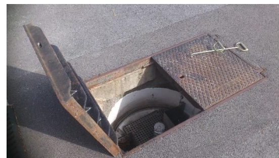
Implantation sous voirie avec accès total
