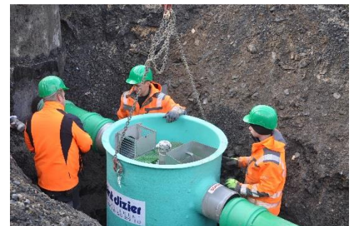
Einbau des STOPPOLs®
