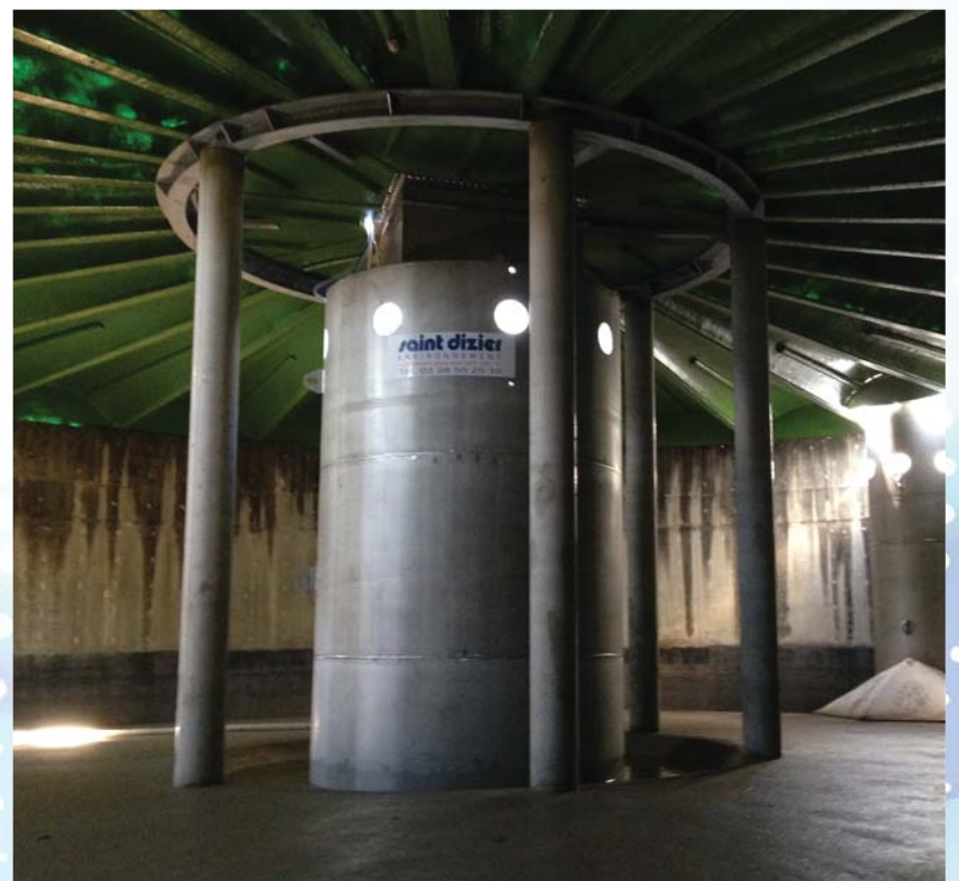
Vue intérieure du bassin
