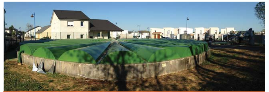
Vue extérieure du bassin
