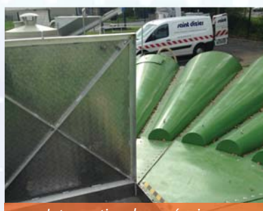
Intervention de nos équipes pour la mise en service
