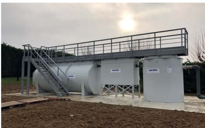
Filière de traitement des eaux de ruissellement
